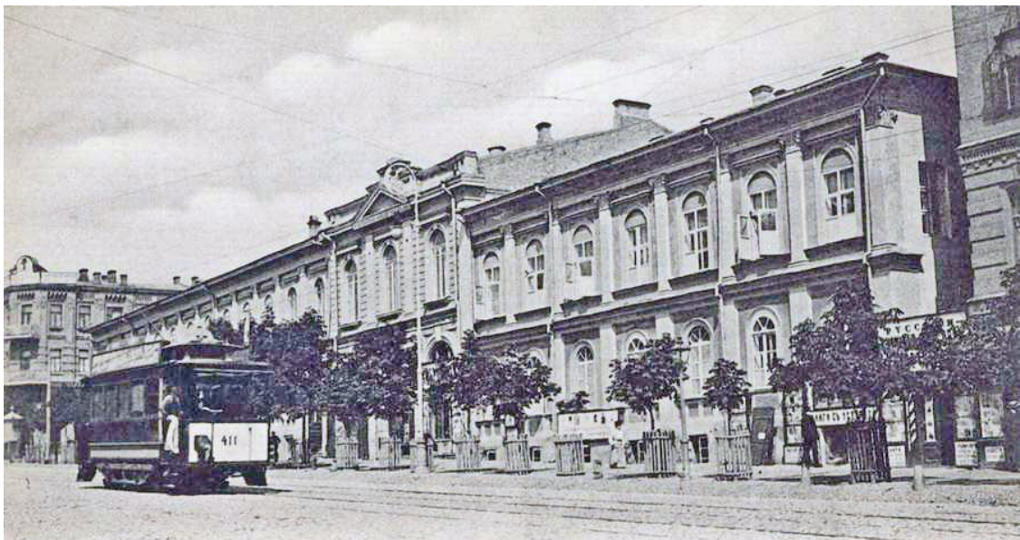
Вул. фундуклеївська (нині - Богдана Хмельницького), 6
