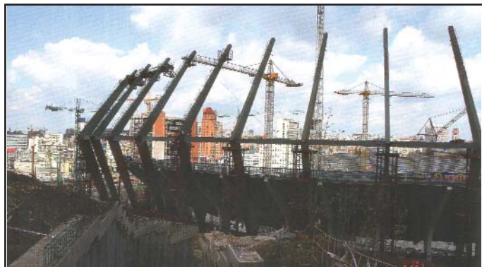
Строительство на НСК "Олимпийский" в 2010 г.
