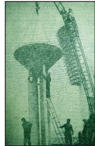
Установка чаши олимпийского огня на Центральном стадионе
