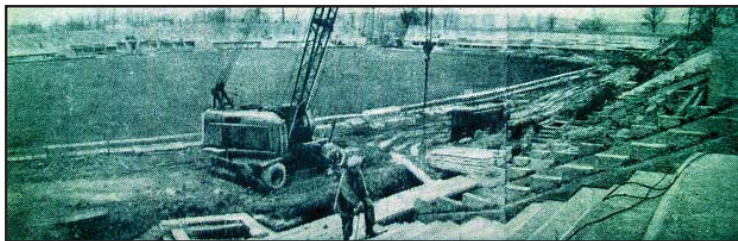
Панорама строительства стадиона КВО в апреле 1965 г.
