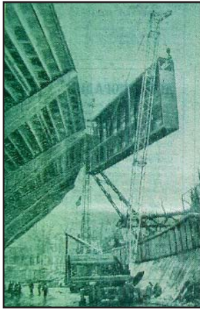
Монтаж электронного табло
