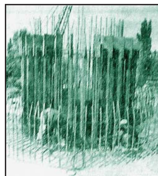
Строительство основания осветительной башни на Центральном стадионе
